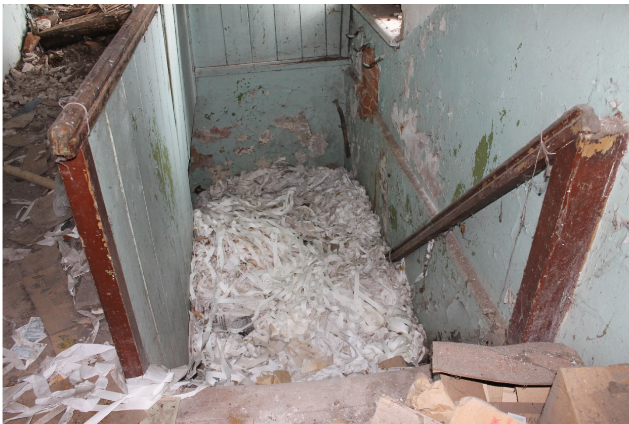
Фото № 27. 2-й этаж. Лестница в юго-западной части здания. «Усадьба купцов Меньшиковых», XIX в. Демин Б.О., 12.11.2020 г.
